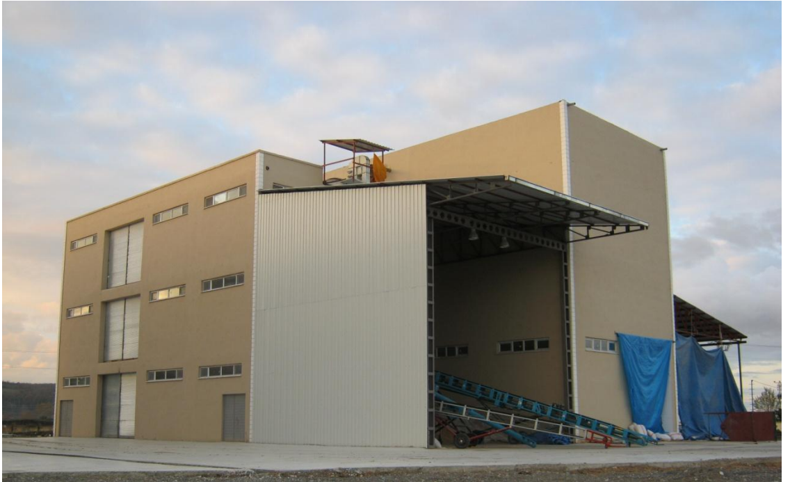
Fotoğraf 11: Barışçıl Gıda Pirinç Üretim Tesisi (Bafra)
